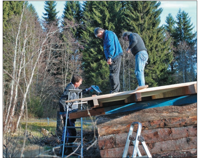
Fra vestre Edvin Garberg, Sverre Nilsen og Ingar Hammerfjell i faglig diskusjon om legging av taket.
